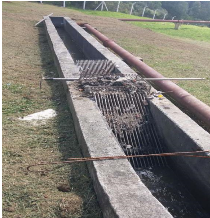
Figura 3.2 – Gradeamento.
